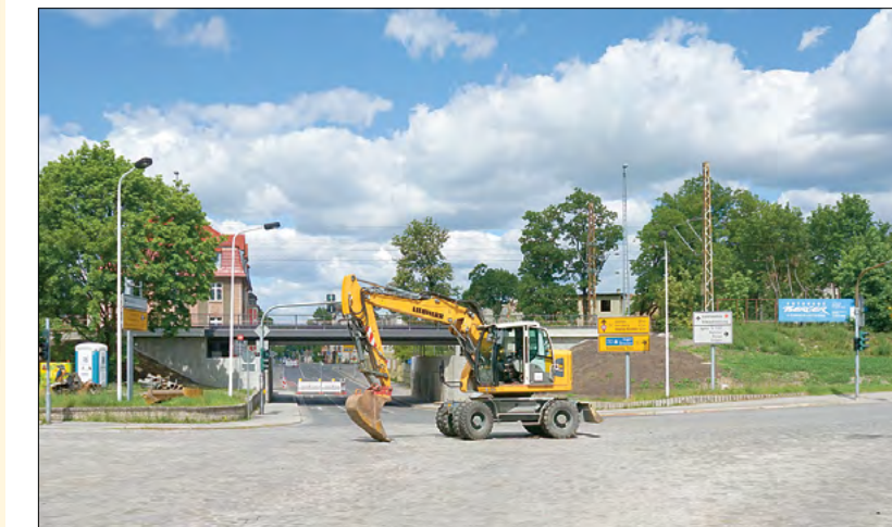
Die Bauarbeiten an der Berliner Straße – hier ein Blick auf die Kreuzung mit dem zukünftigen Kreisverkehr.
