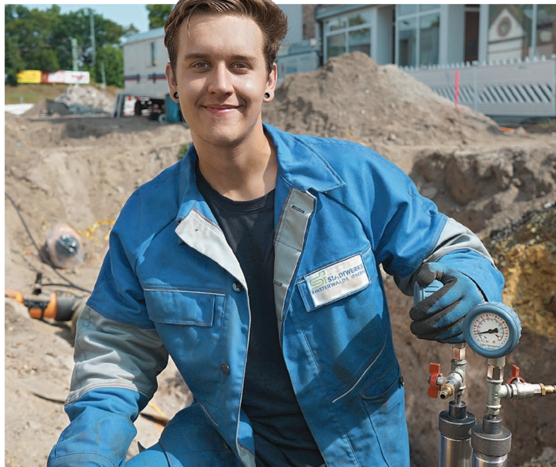
Unser Monteur Justin Höhne vom Gas- und Wassernetz überprüft die Absperrung der Erdgasleitung, bevor die Leitung neu angebunden wird. Foto: SF
