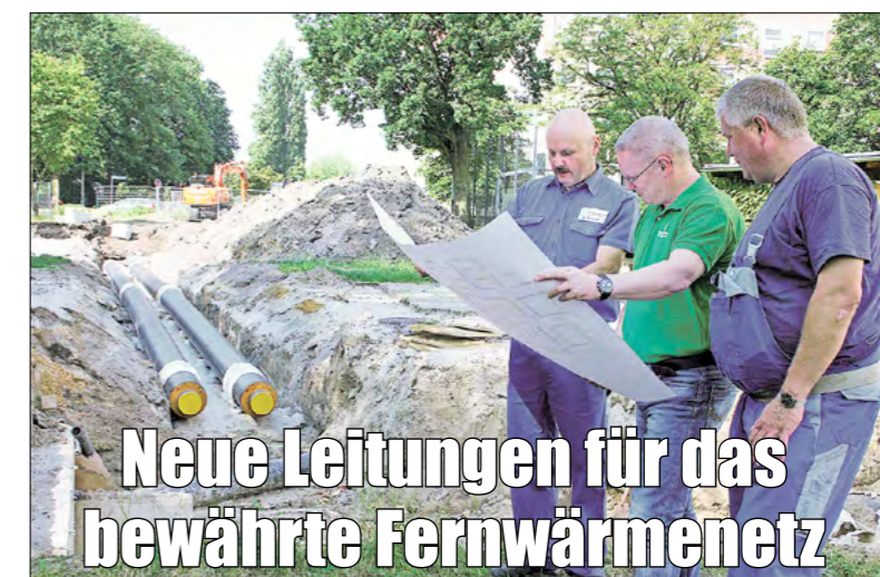
Das SF-Wärmeteam begutachtet den raschen Fortschritt der Bauarbeiten Ecke Geschwister-Scholl-Straße und Holsteiner Straße.
