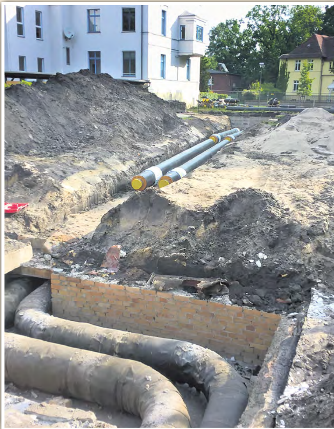
Der Unterschied ist gut zu erkennen – im Vordergrund liegen die alten Fernwärme-Rohre, die mit Dachpappe ummantelt sind. Dahinter warten die neuen Kunststoffmantelrohre mit integrierter Isolierung auf ihren Einsatz.
