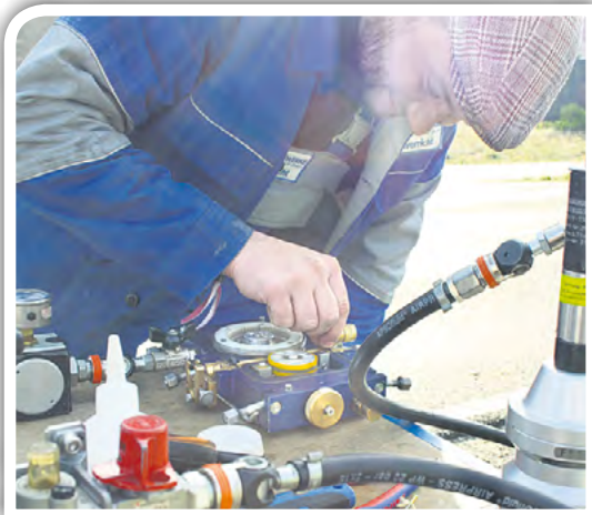
Monteur Marius Unverricht beim Einblasen des Glasfaserkabels.
