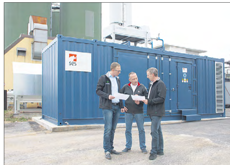
Beide Seiten schätzen die partnerschaftliche Zusammenarbeit: Frank Steinberger, Projektingenieur Energieversorgung bei der PROWIB (M.) sowie SF-Mitarbeiter Jörg Lauschke (l.) und Hendrik Helm. Im vergangenen Sommer konnte mit der produzierten Menge an Wärme die Stadt Finsterwalde zu fast 100% versorgt werden.
