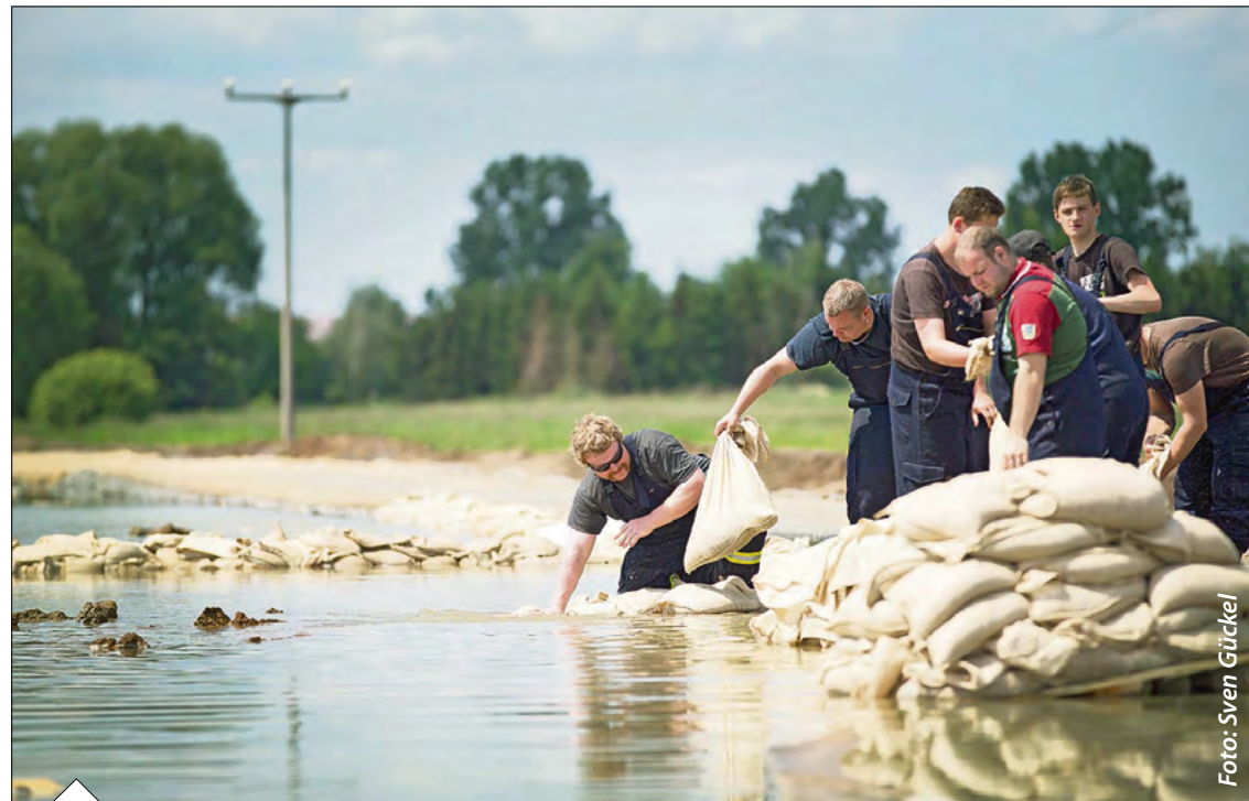
Professionelle Kräfte und freiwillige Helfer stabilisieren während des verheerenden Frühjahrs-Hochwassers 2013 den Deich der Schwarzen Elster an der Landesgrenze zu Sachsen-Anhalt.
