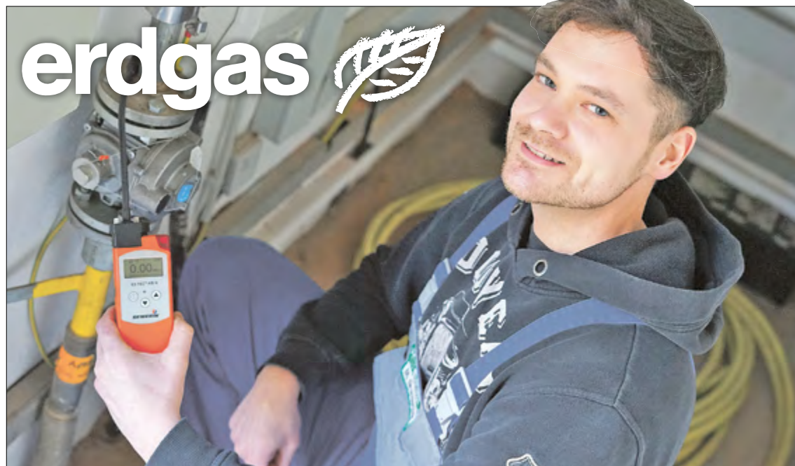
Marco Grundschock, Monteur vom Gas- und Wassernetz der Stadtwerke Finsterwalde, bei der Überprüfung eines Gashausanschlusses. Fünf Mitarbeiter waren in den vergangenen Wochen in Finsterwalde und in Doberlug-Kirchhain unterwegs.
