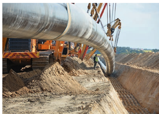
Leitungsbau in Brandenburg: Die Europäische Gas-Anbindungsleitung (EUGAL) transportiert das Gas von der Ostsee ins Landesinnere. Foto: EUGAL
