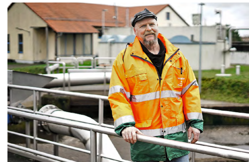
Andreas Mundt auf der Brücke des Belebungsbeckens der Kläranlage Finsterwalde. Der stellvertretende Werkleiter beim Entwässerungsbetrieb erklärt, wie die biologischen Prozesse ablaufen. Foto: SF
