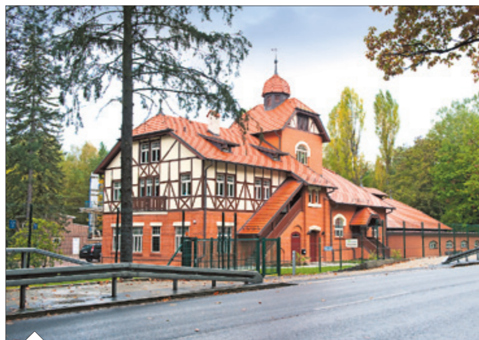
Das prächtige Wasserwerk der Stadtwerke Finsterwalde ist bereits 101 Jahre alt, erfüllt seinen Zweck aber zuverlässig wie eh und je.
