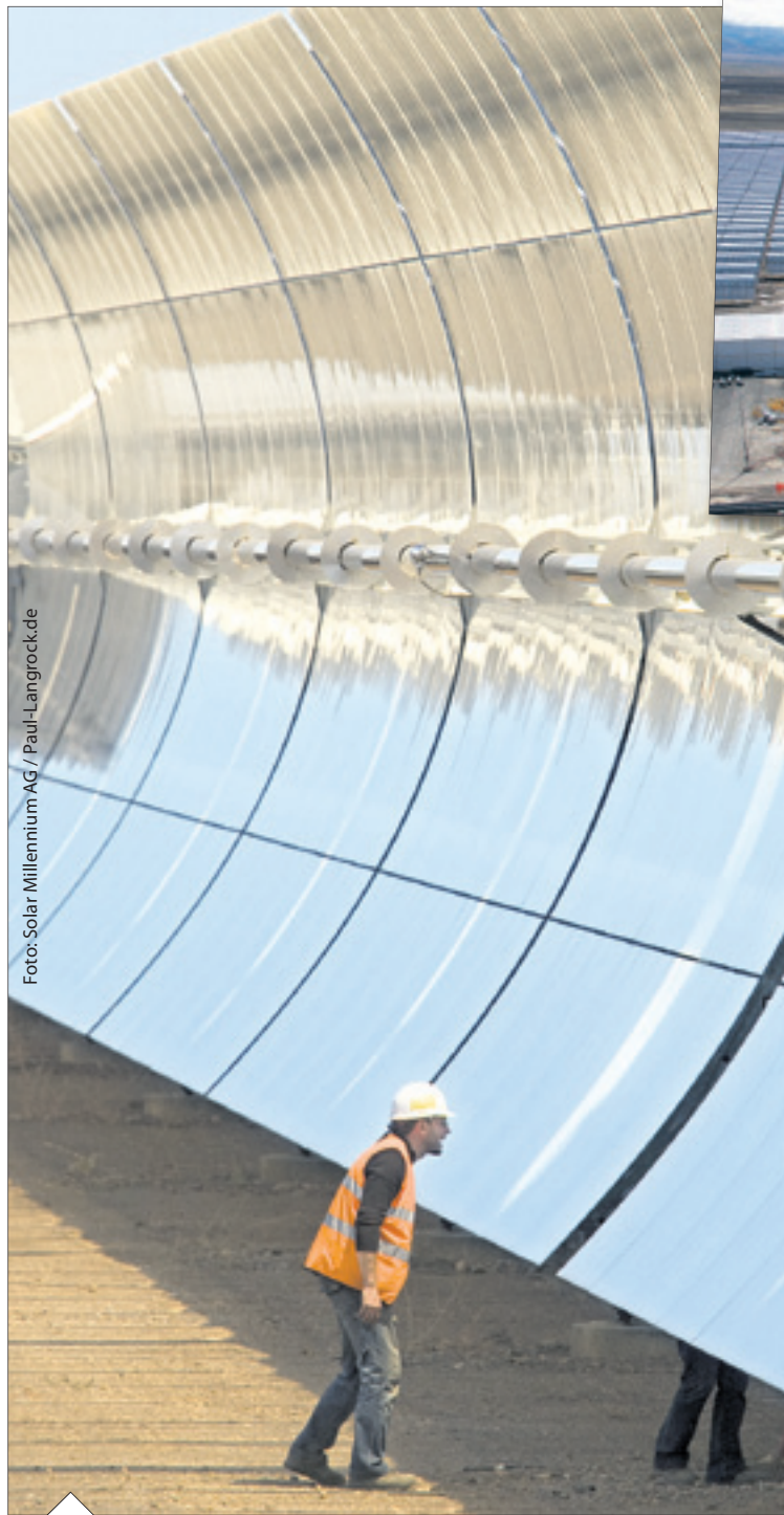
Das solarthermische Kraftwerk Andasol im südspanischen Andalusien ist das erste europäische Parabolrinnen- und weltgrößte Solarkraftwerk.
