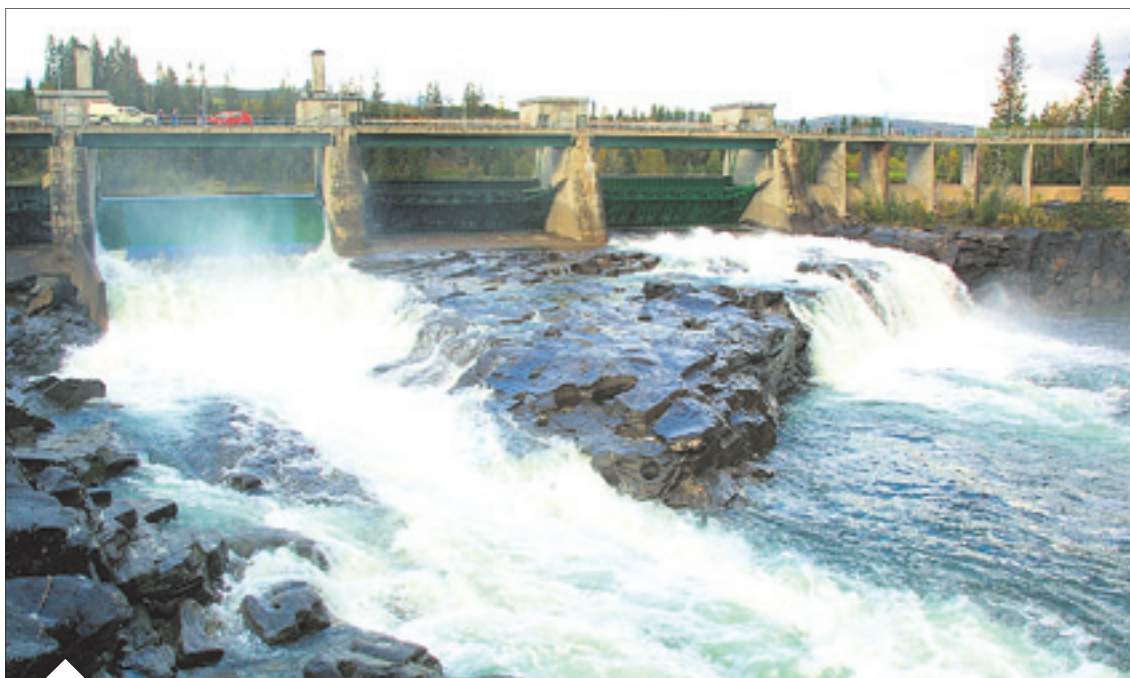
Der größte Stromproduzent Norwegens ist der Konzern Statkraft, der auch außerhalb der Landesgrenzen aktiv ist. Bereits seit 1895 wird in dem Land Energie aus Wasserkraft erzeugt, 2008 waren es 99,3 % des Gesamtverbrauchs.
