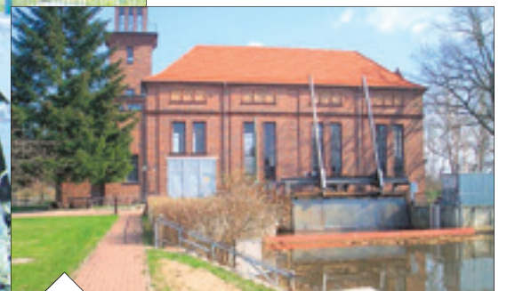
Im Jahr 1929 ging die Wasserkraftanlage Grießen erstmals in Betrieb, sie wurde 1992 reaktiviert. Die Anlage der Firma Kössler hat eine Wellenleistung von 536 kW, bei einer Nettofallhöhe des Wassers von 3,80 m.
