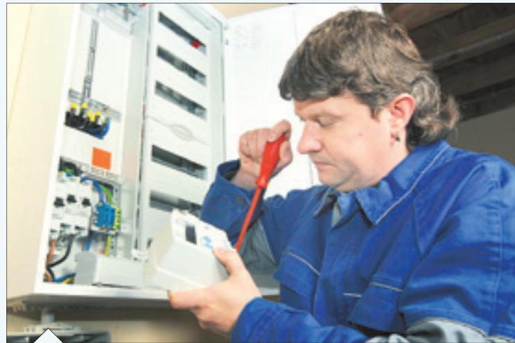
Zählermonteur René Stephan beim Einbau eines Smart Meters.
