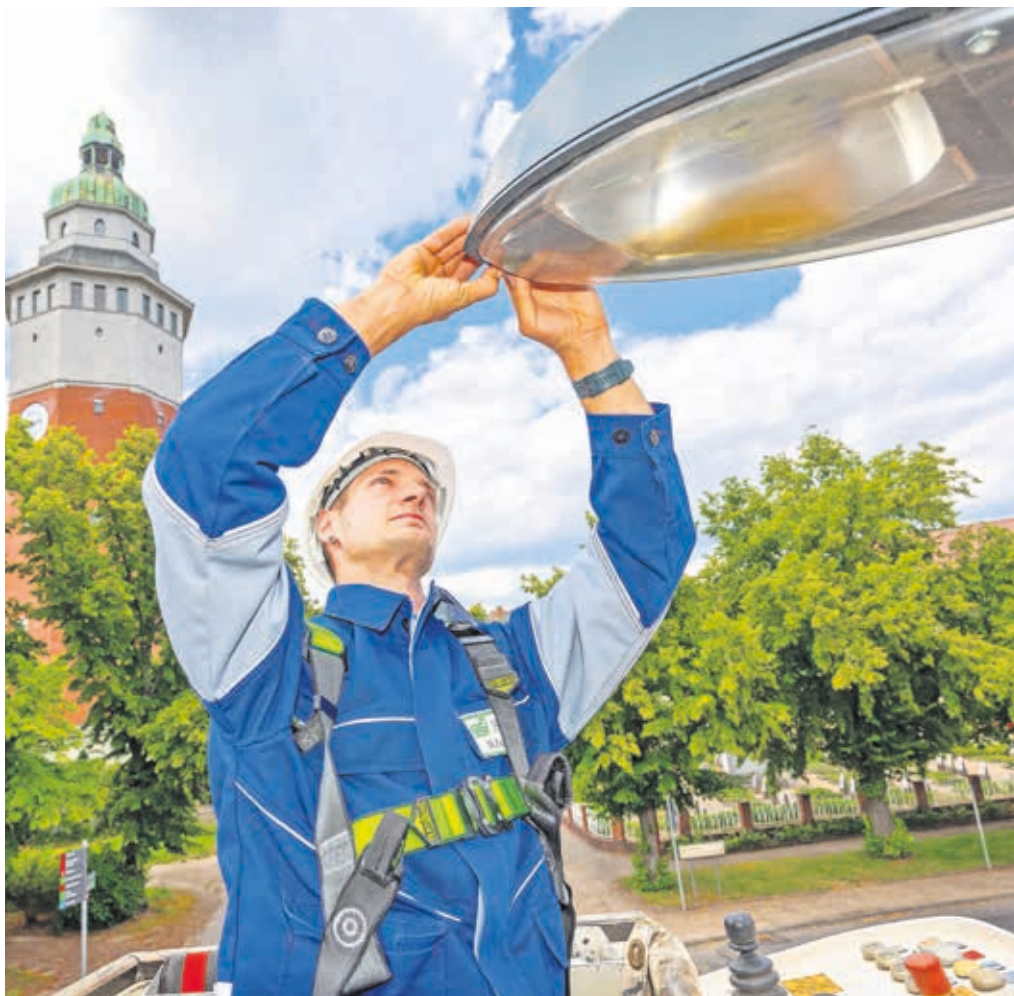
Steffen Eckhardt bei Instandhaltungsmaßnahmen der Straßenbeleuchtung
